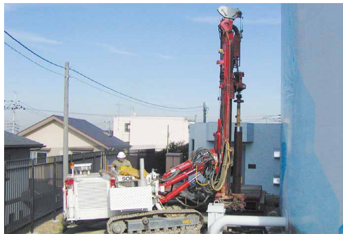
杭径 \phi 267.4mm、L=7m
