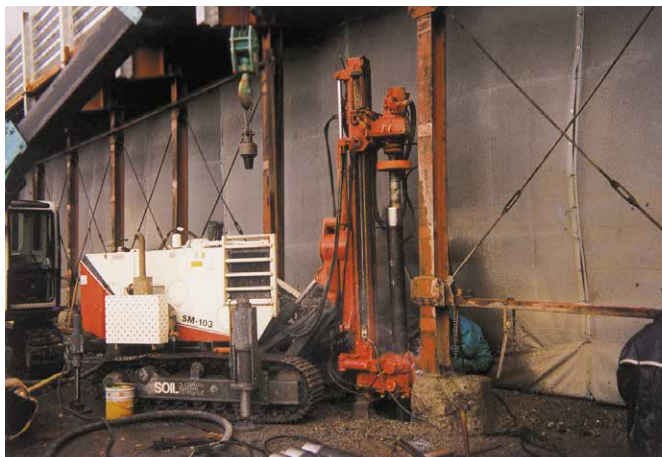
杭径 \phi 165.2mm、L=10.5～16.5m
