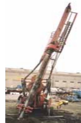
斜杭施工状況
