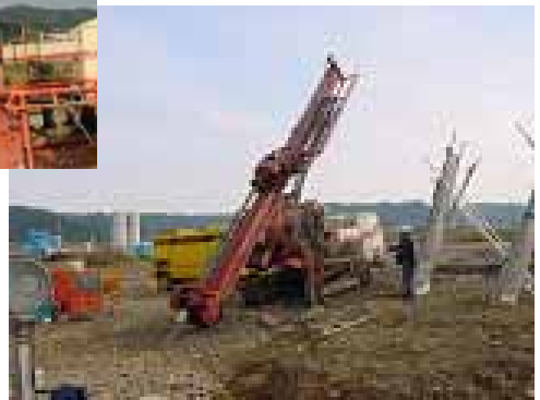
斜杭削孔状況 =45°
