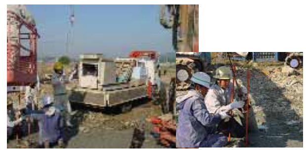
ジャイロ式穴芯測定器による削孔精度測定状況
