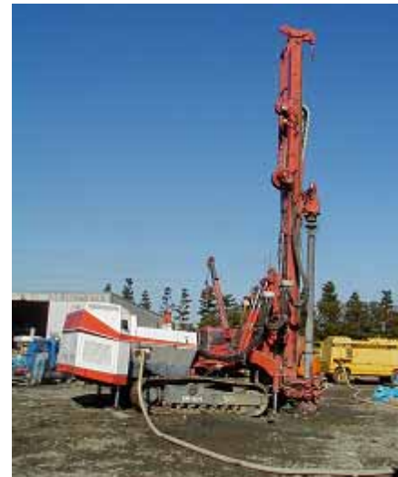
試験状況(削孔状況)
