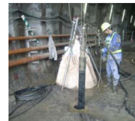
パッカー注入状況
