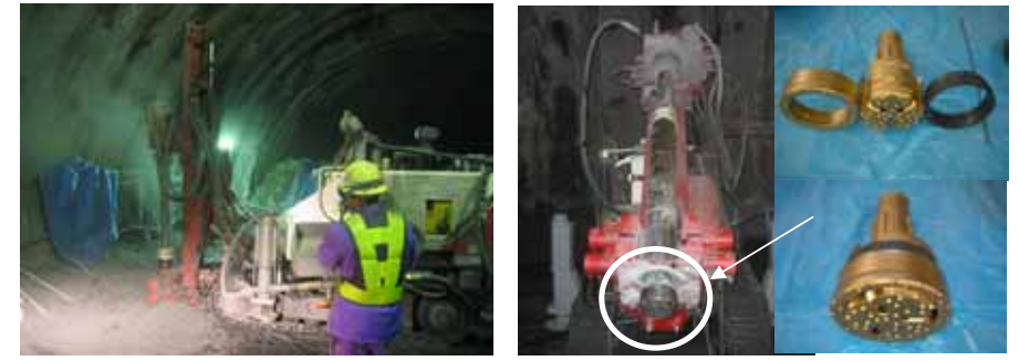
施工状況写真
