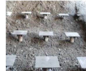
頭部処理状況
