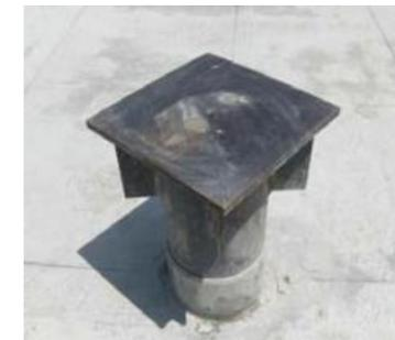
機械式継手 頭部処理完成
