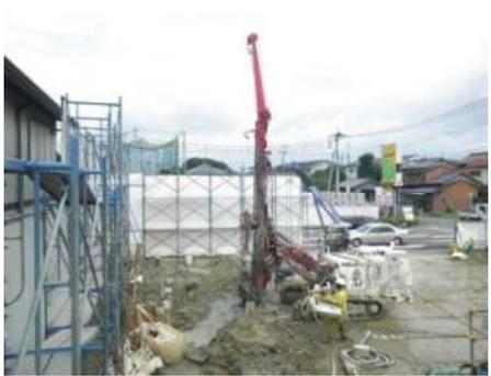
削孔・鋼管打設状況
