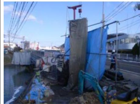
A3橋台 施工状況(飛散防止対策)
