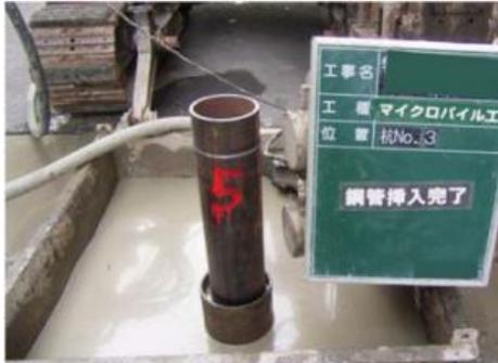
鋼管挿入完了
