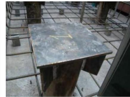
施工完了全景(支圧板取付後)
