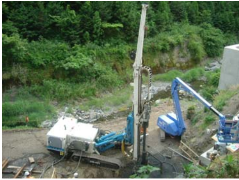
写真-1.3.3 削孔機械 SM401
