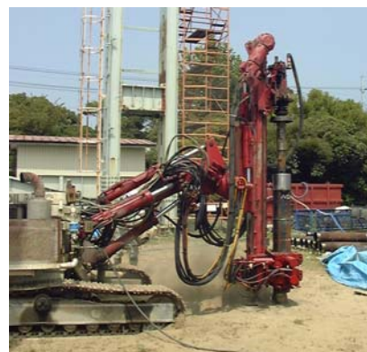
写真-1.3.2 D.T.H による削孔状況
