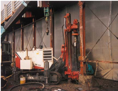
写真-1.3.5 削孔機械 SM103
