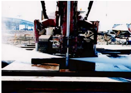
写真-2.3.5 清水高压喷射状况
