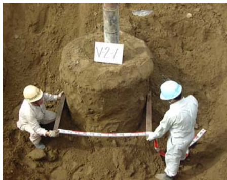
写真-2.3.7 改良体造成状况(砂质土)
