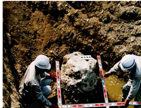
写真-2.3.6 改良体造成状况(粘质土)
